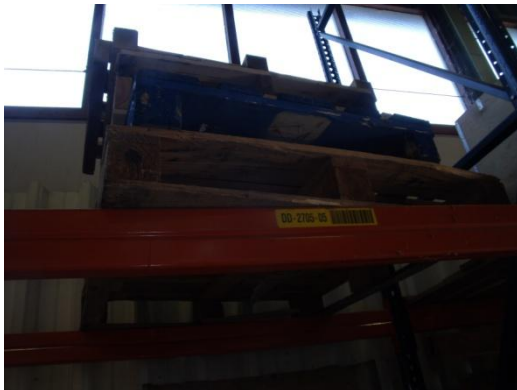
Deze stapeling van pallets is instabiel en scheef
